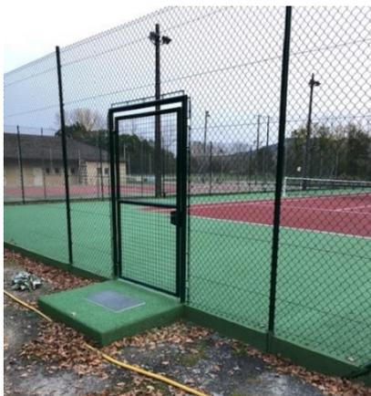
Grillage 3 m de haut. Mise en peinture des poteaux existants. Filets et supports neufs. Mise aux normes de la commande d'éclairage.
