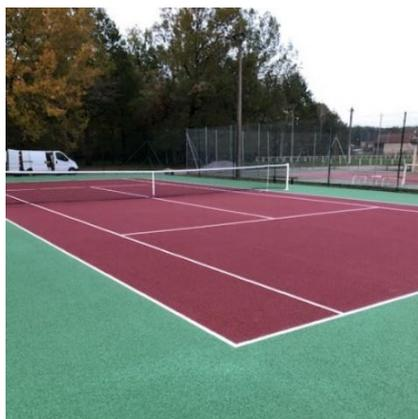
Dalle en béton poreux en conformité avec la norme NFP 90-110 homologuée «compétitions».
